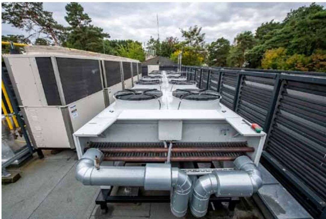
Recooler do odprowadzania nadwyżki ciepła z adsorpcji latem stanowi źródło freecoolingu zimą dla potrzeb schładzania aparatury medycznej
